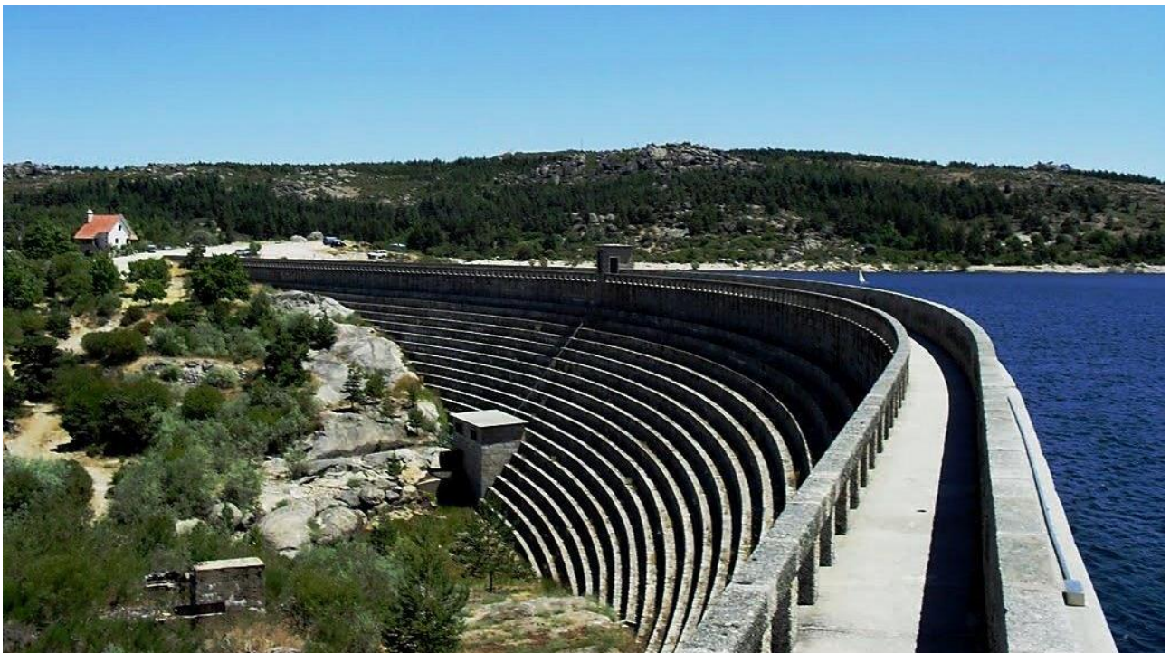
Figura 4. Barragem de alvenaria (Vale do Rossim, Portugal)
