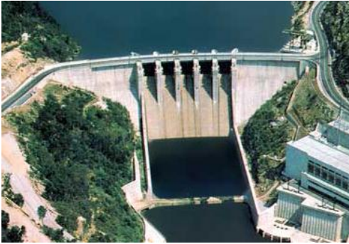
Figura 16. Descarregador sobre a barragem com comporta, queda guiada e obra de dissipação (Torrão, Portugal)
