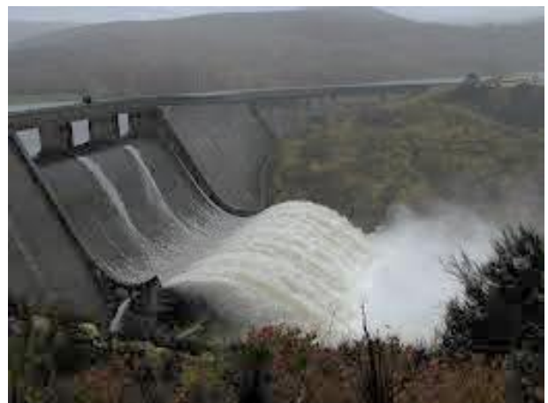
Figura 15. Descarregador sobre a barragem com descarga livre, queda guiada, trampolim e dissipação de energia no leito (Alto Cávado, Portugal)
