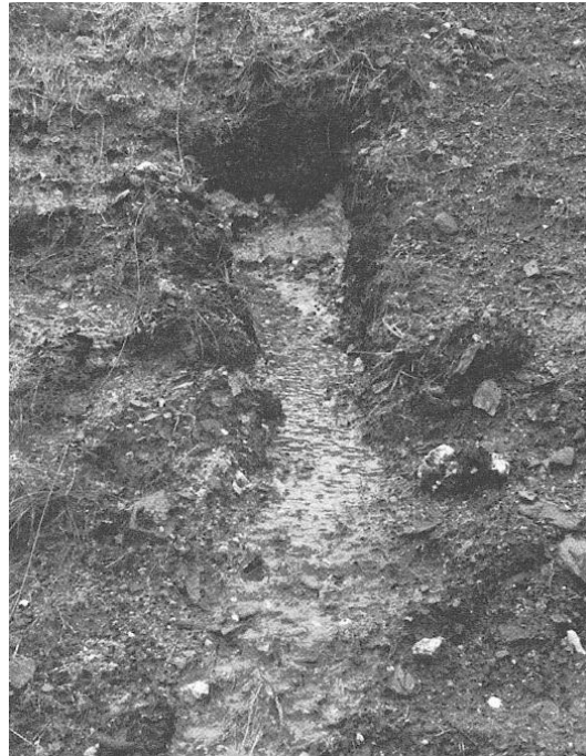
Figura 36. Ressurgência e arrastamento de finos
