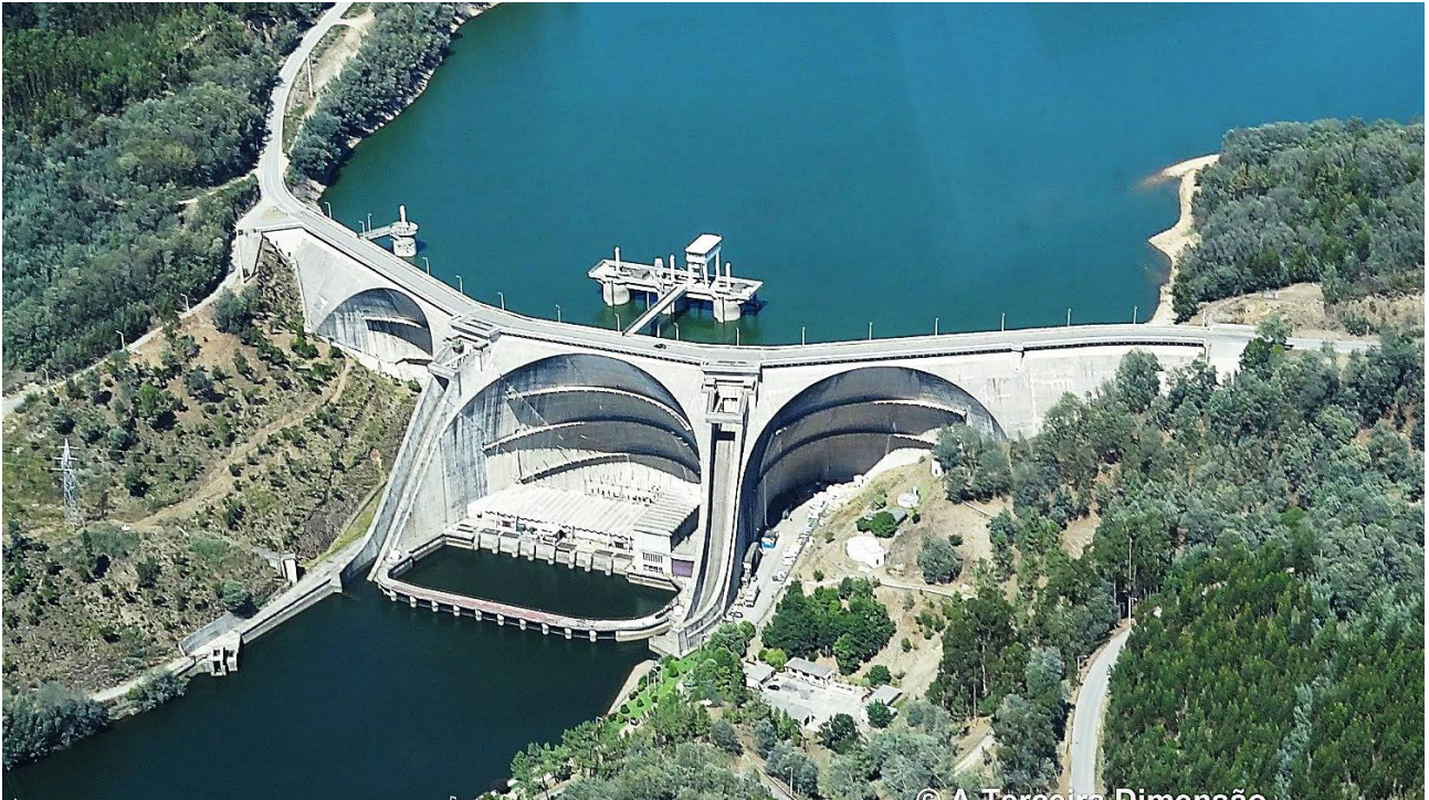
Figura 7. Barragem de abóbodas múltiplas (Aguieira, Portugal)
