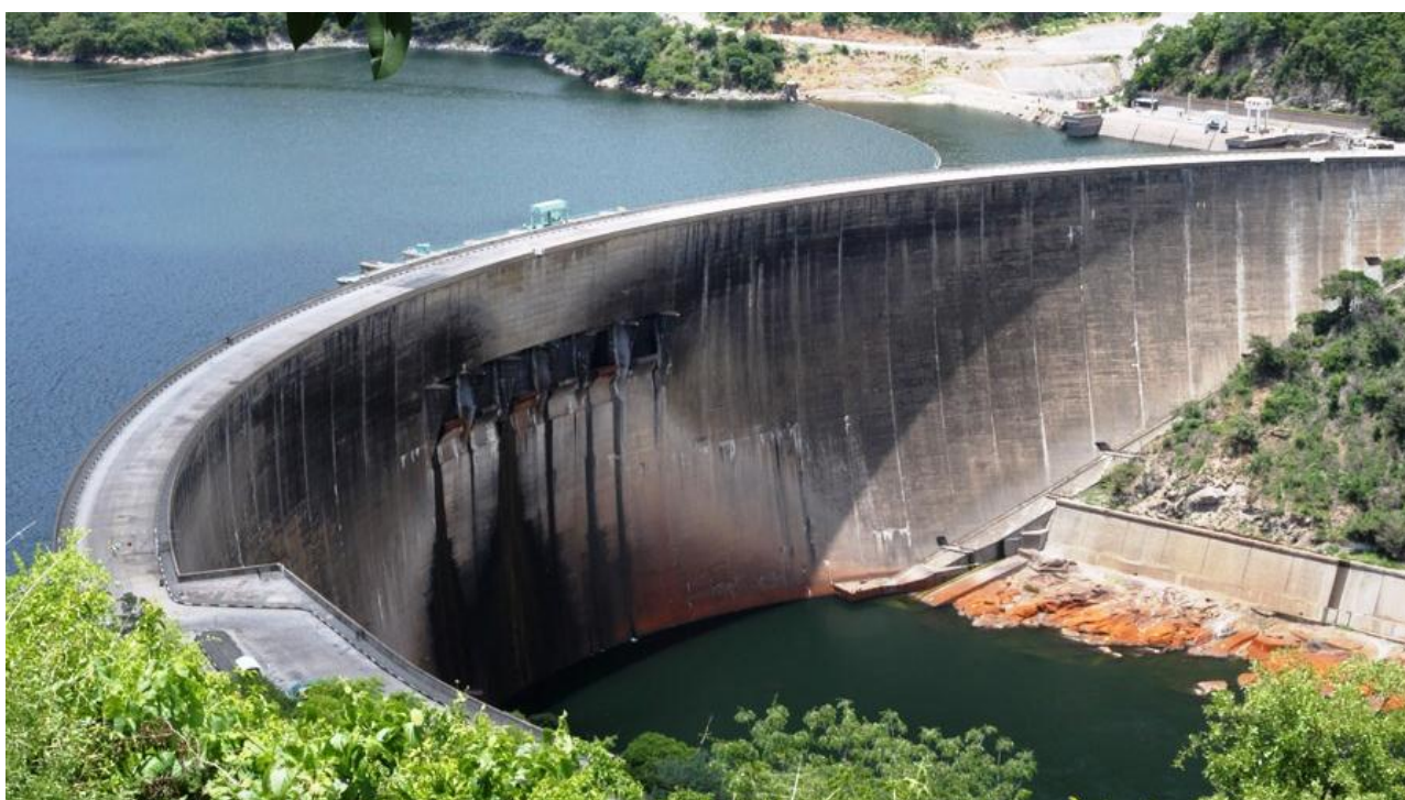
Figura 6. Barragem de arco gravidade (Kariba, Zâmbia/Zimbabué)
