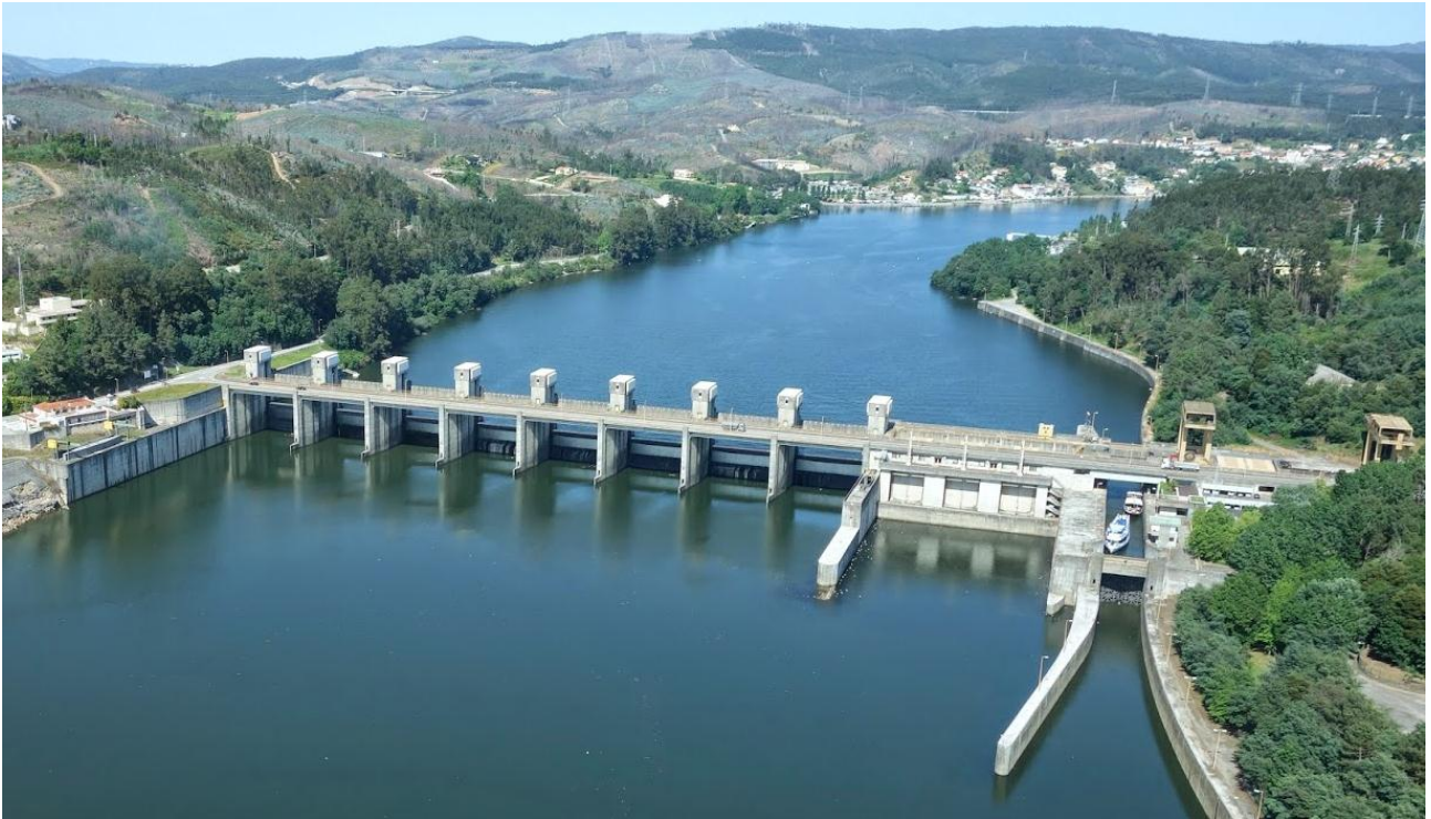
Figura 3. Barragem móvel (Crestuma-Lever, Portugal)
