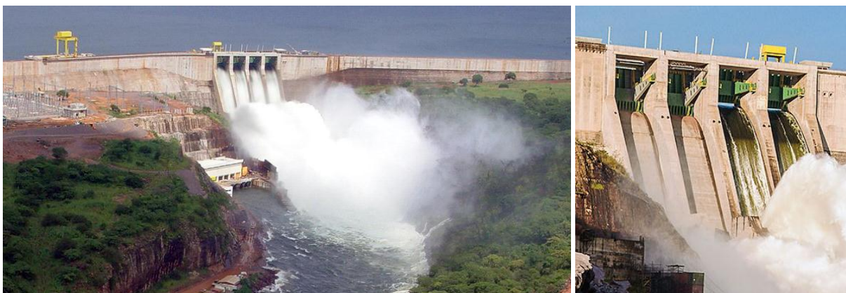
Figura 18. Descarregador de orifício com comporta, queda guiada, trampolim e dissipação de energia no leito (Capanda, Malange, Angola)
