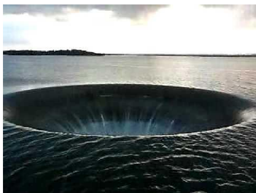
Figura 20. Descarregador de poço (Monte da Rocha, Portugal)
