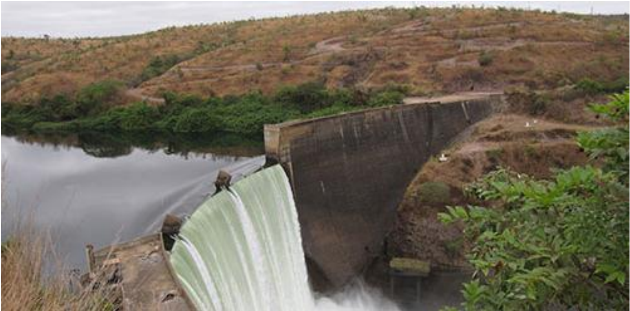
Figura 14. Descarregador sobre a barragem com descarga e queda livre (Cambambe, Cuanza Norte, Angola)
