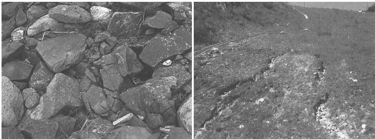
Figura 34. Meteorização do rip-rap (esquerda) e ravinamento (direita)
