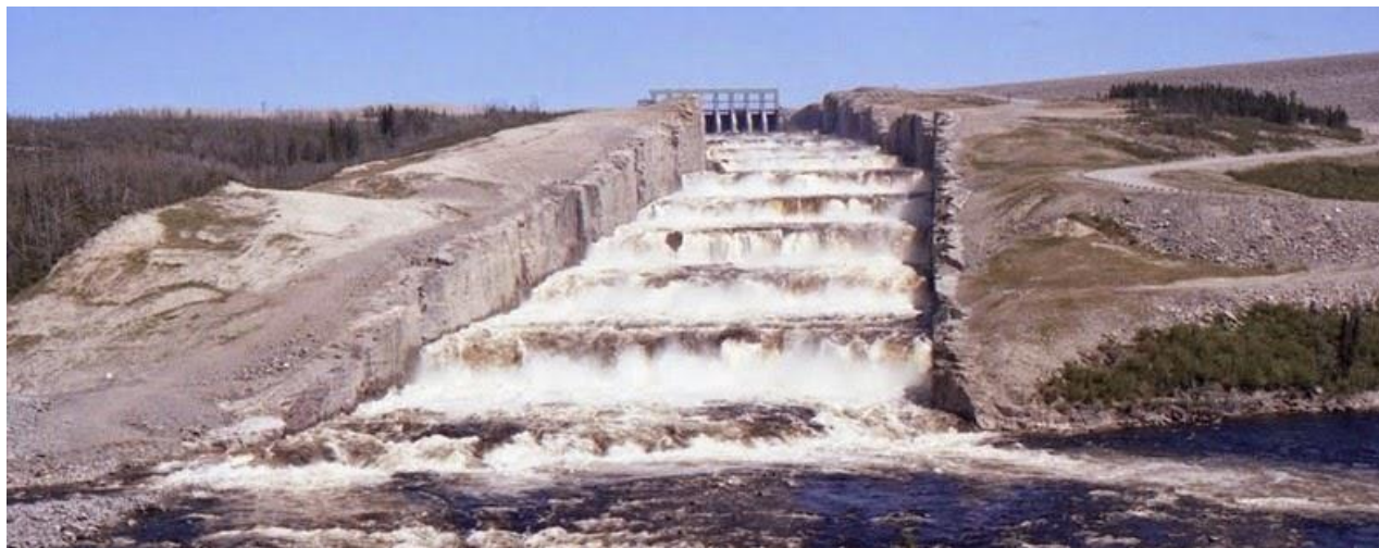
Figura 19. Descarregador em canal de encosta, dissipação de energia por degraus (Robert-Bourassa, Canadá)
