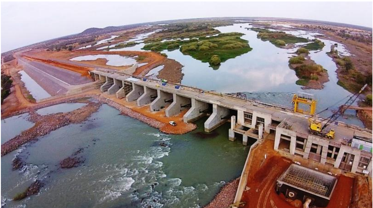
Figura 2. Barragem mista betão/aterro (Calueque, Cunene, Angola)
