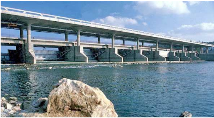
Figura 17. Descarregador sobre a barragem (barragem móvel), com comporta de controlo e bacia de dissipação (Coimbra, Portugal)
