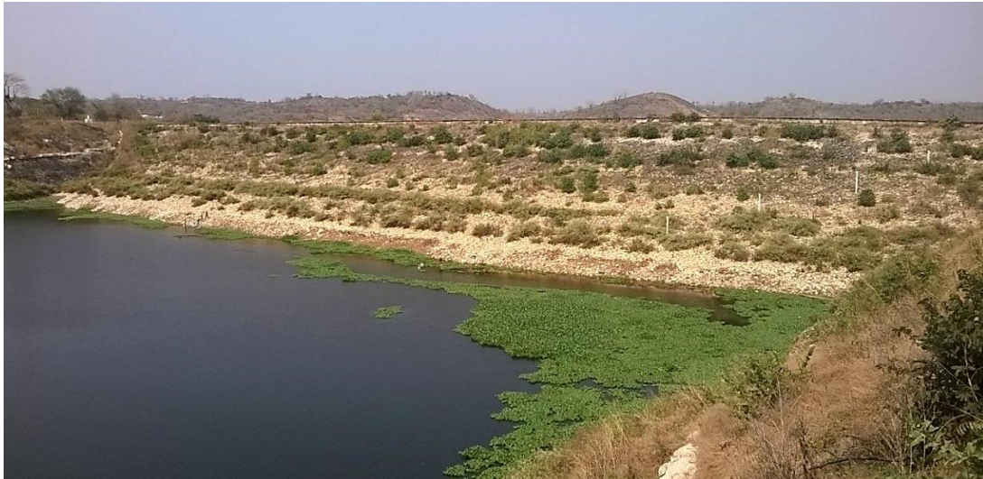
Figura 10. Barragem de terra (Quiminha, Bengo, Angola)
